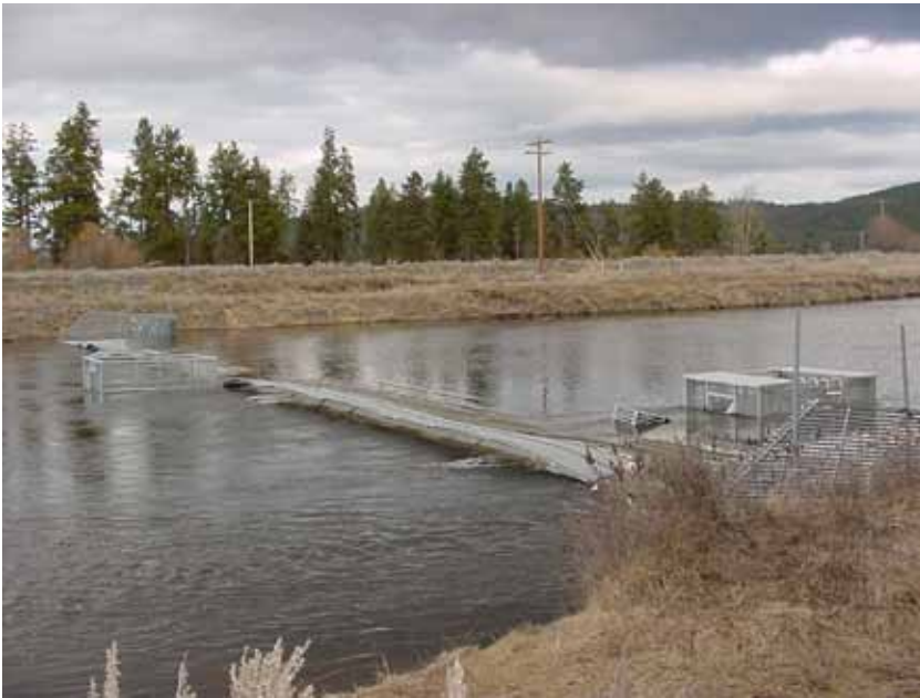
FOTO 3: Flyttbar oppvandingssperre for registrering og forvaltning av vill og utsett laks i Alaska, California og Oregon. (Utlånt av Cramer Fish Science, California).
